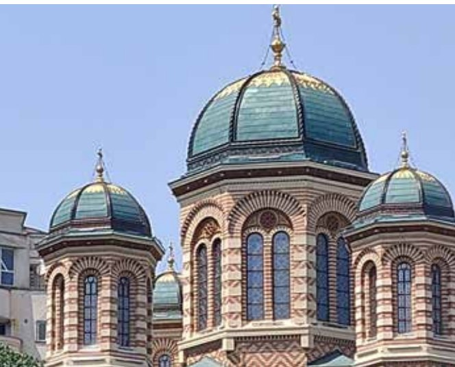
Църквата Domnița Vălașa, Букурещ КМЕ 'TECU@ Patina Oslo' медни ламарини и КМЕ Natural медна система за улици
